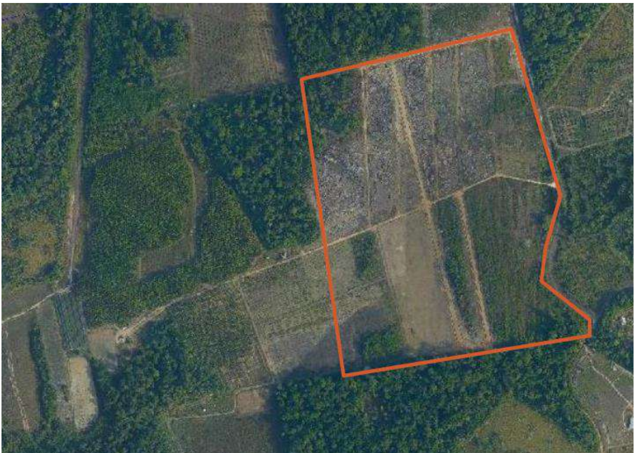
Figure 110 : illustration de l'ampleur du défrichement sur la zone d'emprise du projet en septembre 2020 (Source : BIOTOPE)
